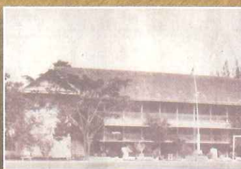
อาคารหลังแรก ณ ริมฝั่งแม่น้ำเพชรบุรี ฝั่งตะวันออก ติดกับถนนบริพัตร
