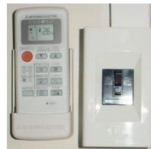
ภาพที่ ๑๕ เบรกเกอร์ (Breaker) ๑ เฟส (แหล่งที่มา : mall.factomart.com )
