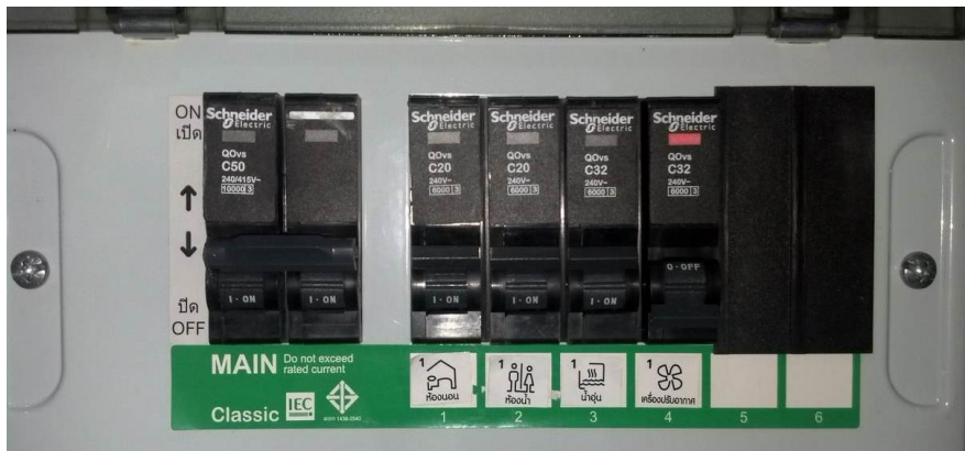
ภาพที่ ๑๗ เบรกเกอร์ (Breaker) ๑ เฟส ในตู้ Consumer Unit (แหล่งที่มา : mall.factomart.com )
