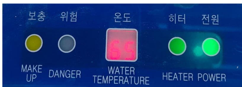
รูปที่ 4-7 หน้าจอแสดงการทำงานของเครื่องช่วยระเหยก๊าซ
