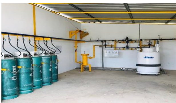
รูปที่ 4-2 การต่อถังก๊าซหุงต้มเข้าระบบ
