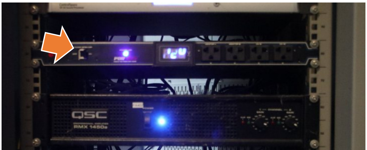
ภาพที่ ๖ ชุดจ่ายไฟเลี้ยงภาคขยายเสียง
