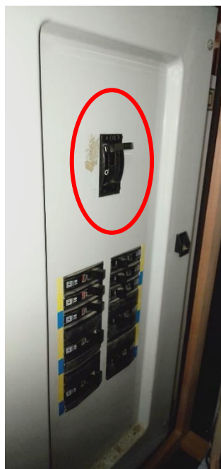
ภาพที่ 3-16 แสดงการปิดระบบไฟฟ้าห้องประชุม แหล่งที่มา : ถ่ายภาพโดยผู้เขียน
