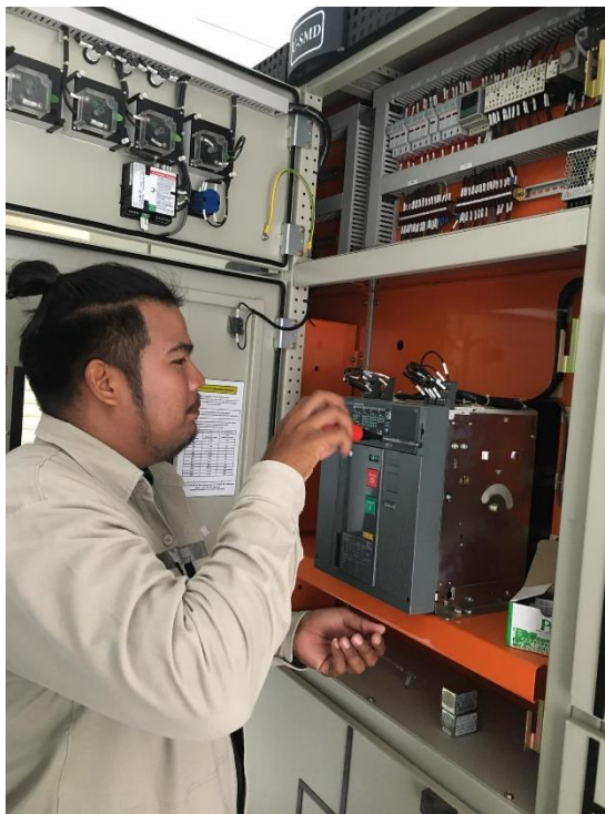
ภาพที่ ๔ แสดงการตรวจสอบระบบไฟฟ้าภายในอาคารเบื้องต้น
